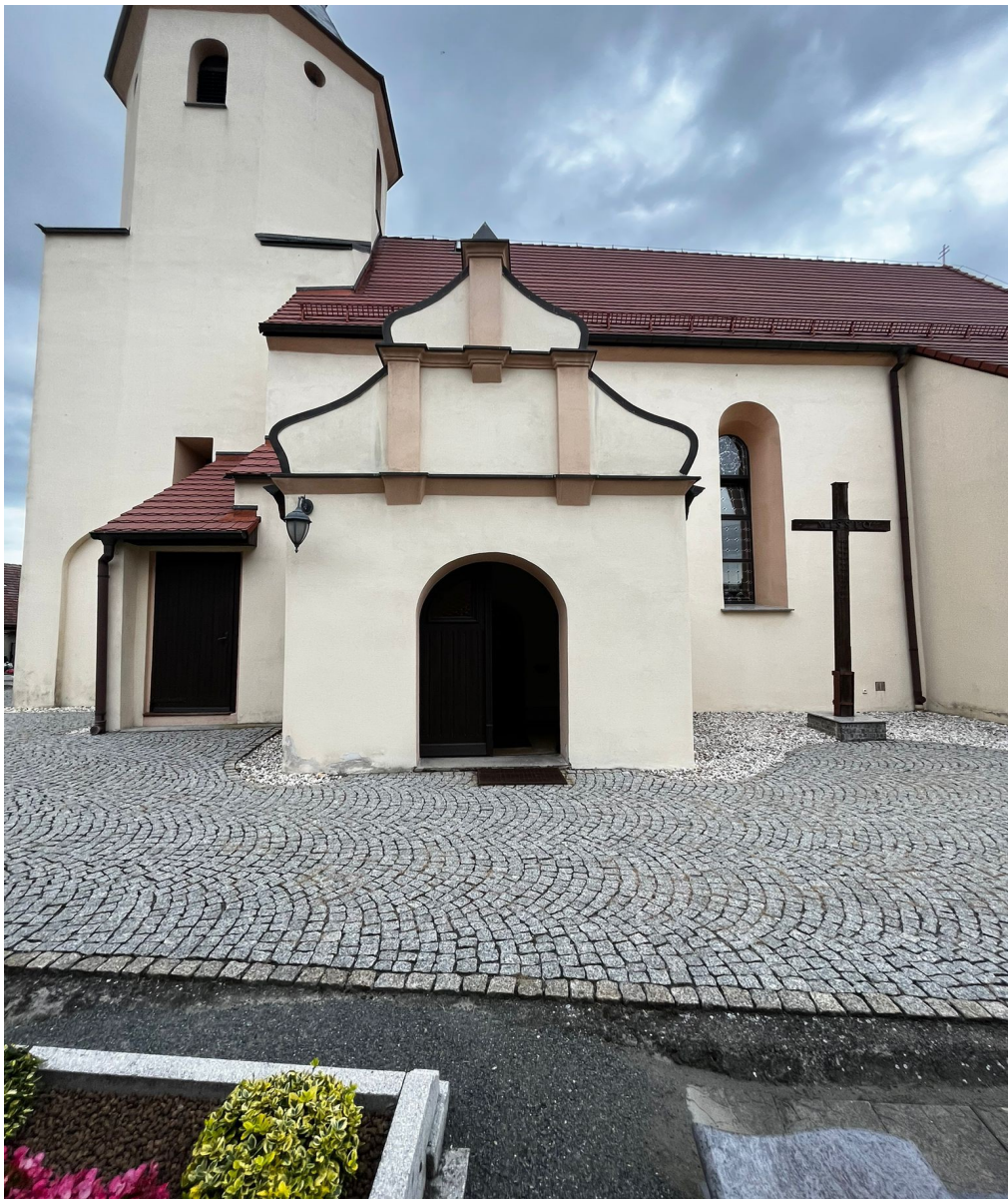
Elewacja południowa kościoła – widok wejścia bocznego
