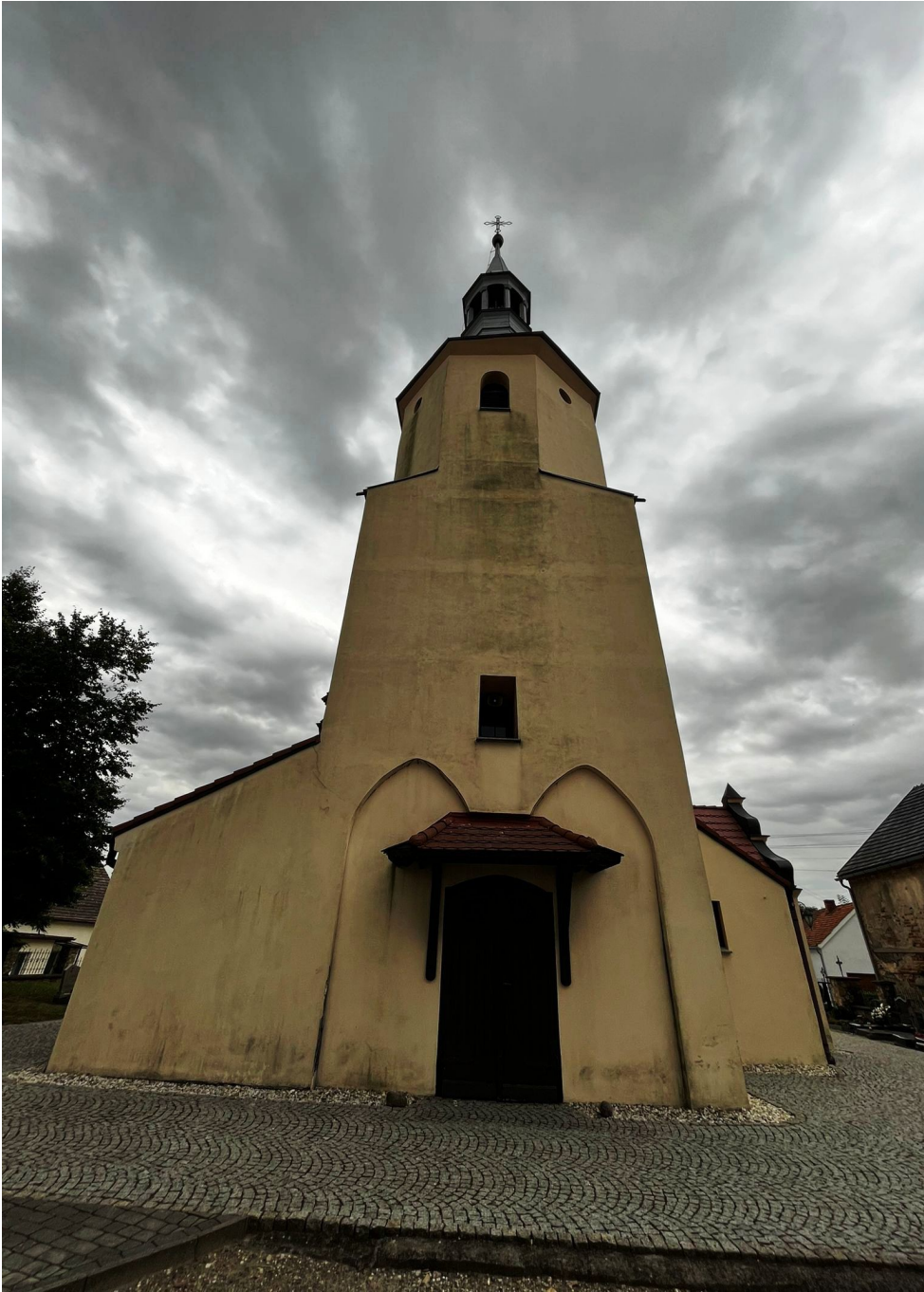
Elewacja zachodnia kościoła – widok wieży
